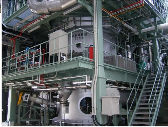
2号汚泥焼却炉長寿命化 下水汚泥を焼却する設備の長寿命化 [築20年経過（標準耐用年数10年）]
