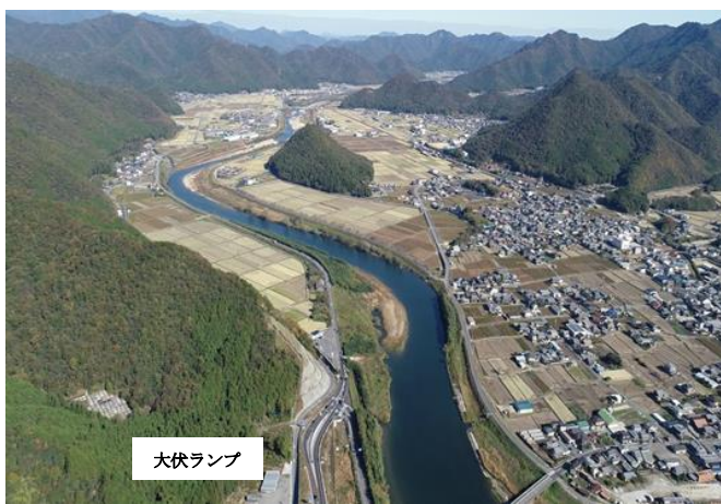
西脇市黒田庄町～丹波市氷上地域の早期事業化 (写真：大伏ランプより北側)
