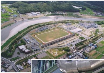
兵庫県加古川上流浄化センター
