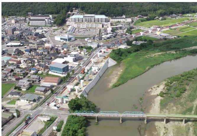
令和8年春開通に向け整備が進む西脇北バイパス (写真：下戸田～津万ランプ(仮称))
