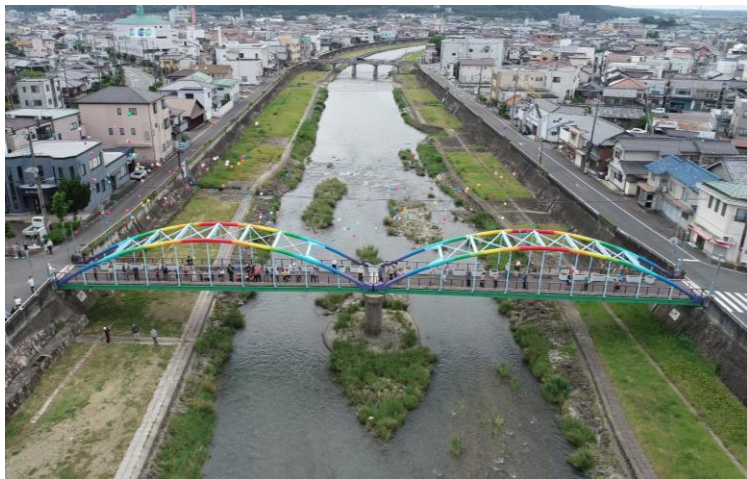
長寿命化の完了した豊川歩道橋 (西脇市西脇)
