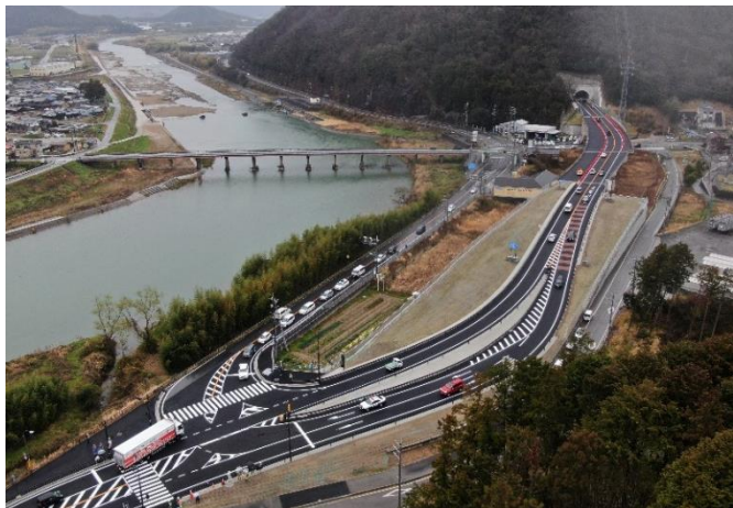
令和2年3月に部分開通した西脇北バイパス 寺内ランプ～大伏ランプ間 (写真：大伏ランプ)
