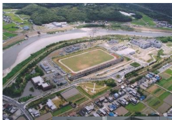
兵庫県加古川上流浄化センター
