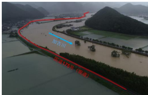
平成30年7月豪雨時の 国道175号周辺の浸水状況 〔西脇市黒田庄地区〕
