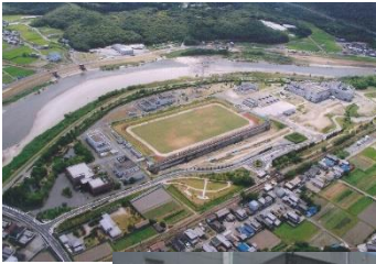
兵庫県加古川上流浄化センター
