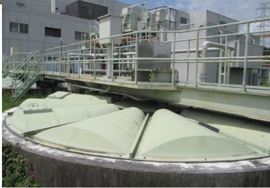
重力濃縮設備改築 下水汚泥を濃縮する設備の改築更新 [築33年経過（標準耐用年数15年）]
