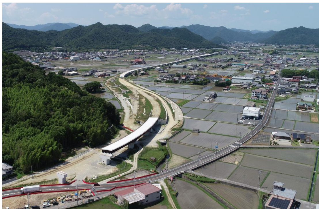
令和8年春の供用に向けて工事の進む西脇北バイパスの（仮称）津万ランプ付近
