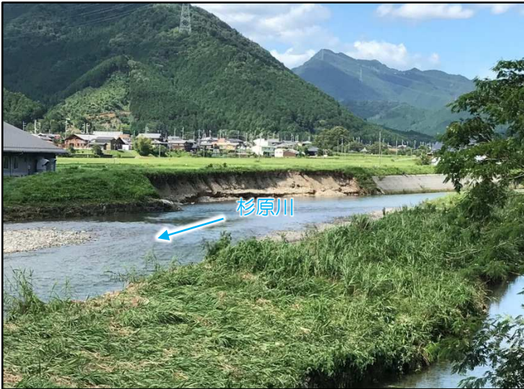
(一) 杉原川 増水による堤防崩壊 (多可郡多可町加美区豊部)
