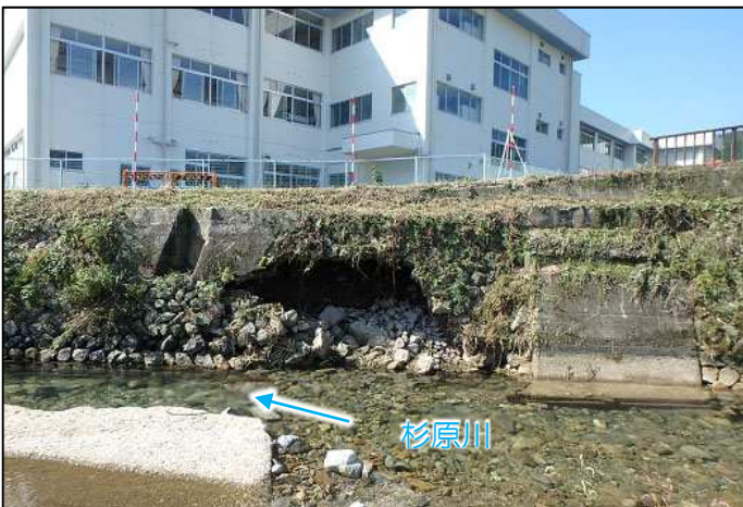
(一) 杉原川 増水による法面崩壊 (多可郡多可町加美区熊野部)
