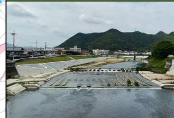
5- (2) 杉原川 沖田井堰上流の 河床掘削・護岸整備 (西脇市西脇～郷瀬町地内)
