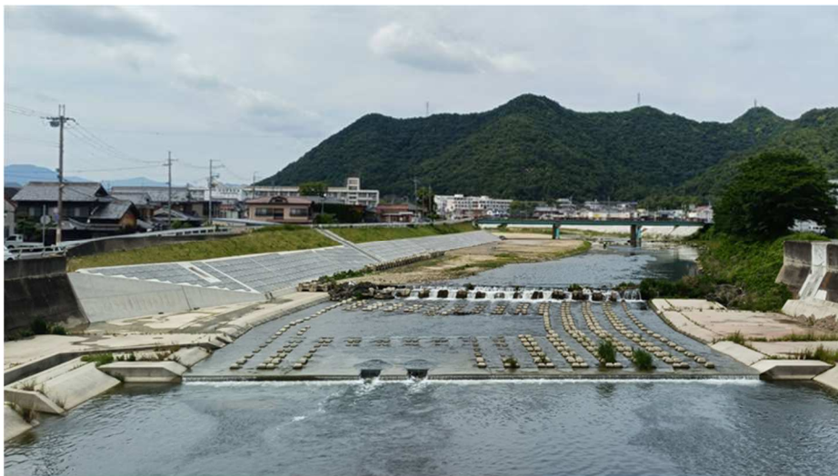
護岸整備の進む沖田井堰周辺（杉原川・西脇市西脇周辺）
