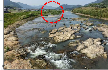
5-(1) 加古川 河床掘削 (西脇市堀町～黒田庄町小苗地内)
