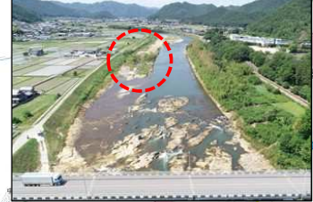
5-(1) (西) 加古川 河床掘削 (西脇市堀町～黒田庄町小苗地内)
