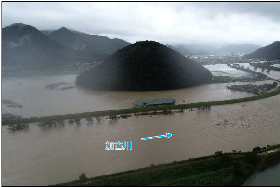
(一) 加古川周辺 浸水被害 (西脇市黒田庄町前坂)
