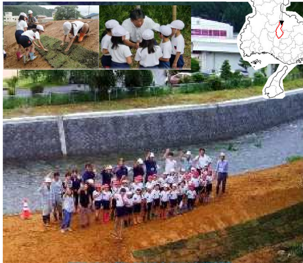
環境体験学習水辺の生き物や河川堤防について 2018.6.20 松井小学校3年生 堤防に芝張り作業体験
