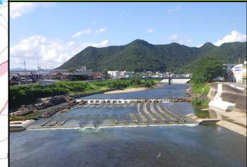
5-(2) (西) 杉原川 沖田井堰上流の 河床掘削・護岸整備 (西脇市西脇～郷瀬町地内)
