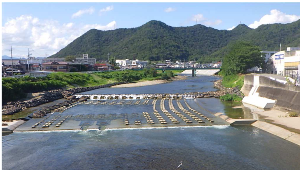
沖田・和田井堰の完成（杉原川・西脇市西脇周辺）
