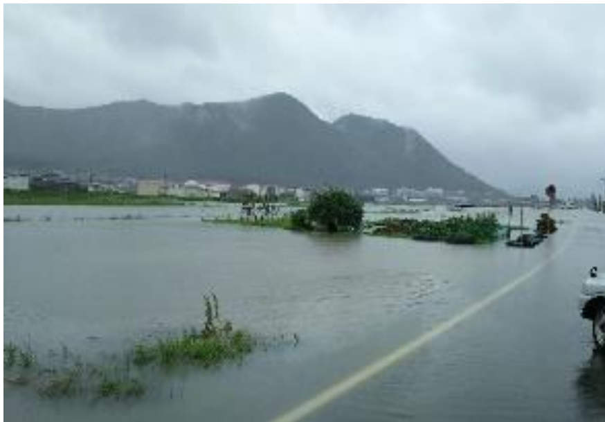
西脇市黒田庄町前坂地内浸水状況（平成30年7月豪雨）
