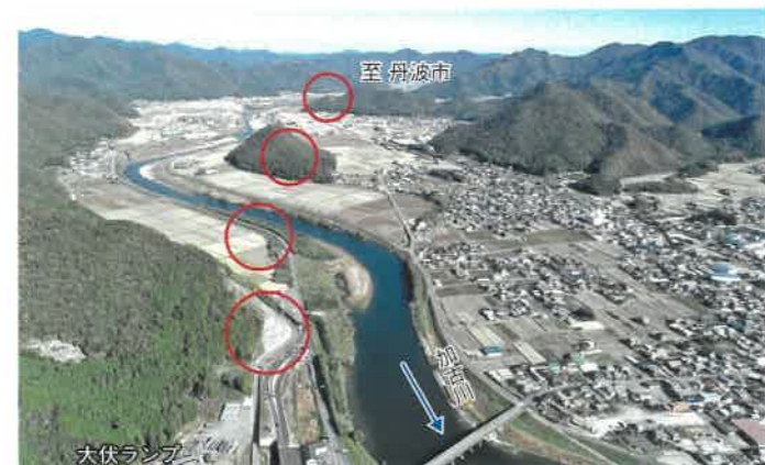
①西脇市大伏ランプより丹波市方面を望む
