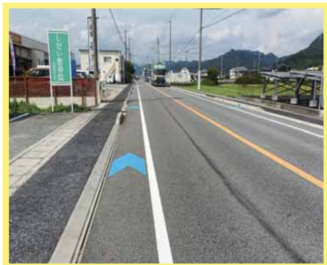
歩道整備済み区間
