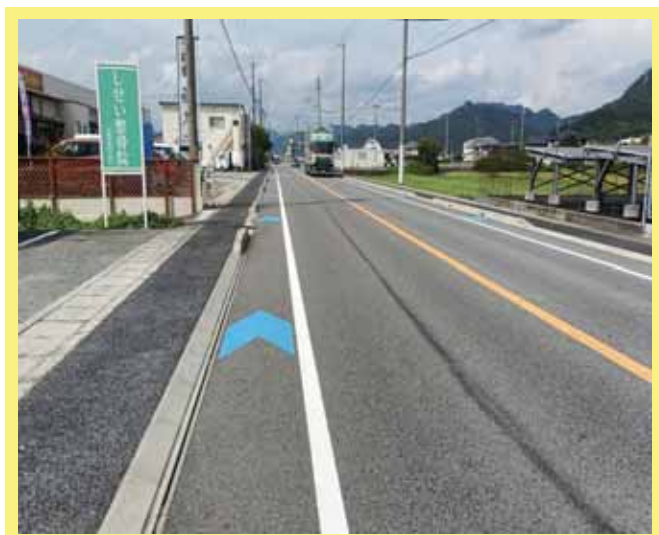
歩道整備済み区間
