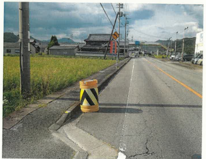
歩道未整備区間
