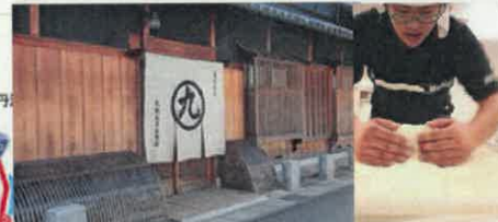
西脇市黒田庄地区に半世紀ぶりの酒蔵が誕生 2020年2月竣工
