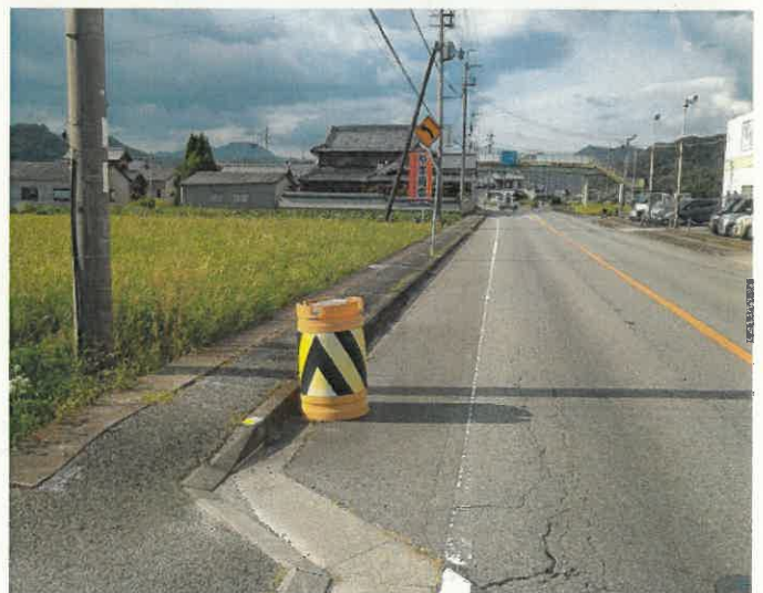
歩道未整備区間
