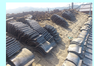
土葺き瓦屋根
