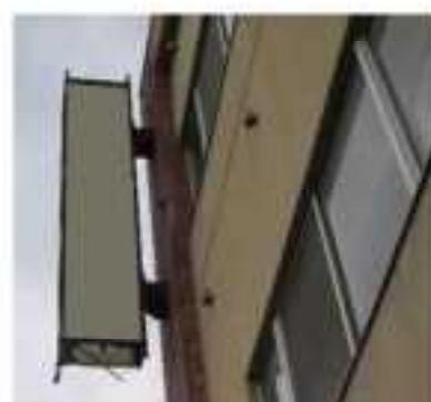
腐食を放置し、底部に穴が空いた例
