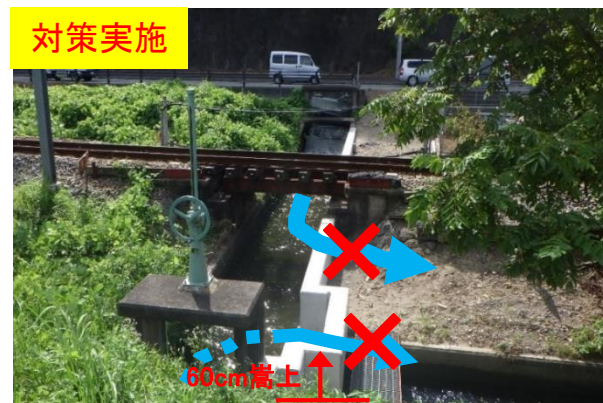
[30年7月豪雨時] 加古川の水位上昇に伴い、加古川へ排水できなくなった上流部（流域外）の雨水が用水路を伝わり流入し、浸水した
