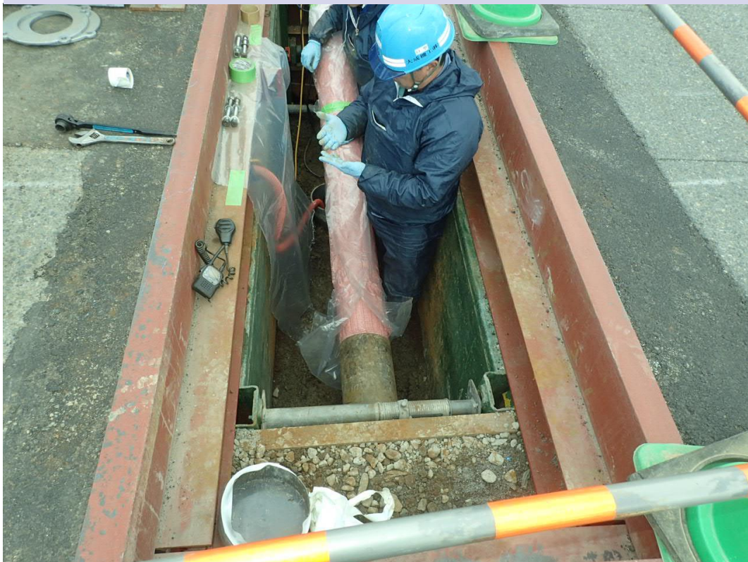
老朽管更新工事(軌道下)管更生工法
