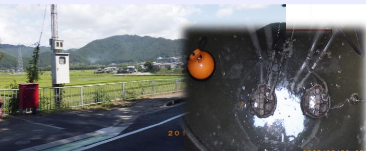
H30-31 小苗8号中継ポンプ場切替作業
