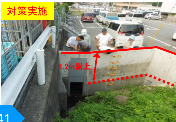
逆流により浸水した箇所の雨水樹の壁高を1.2m嵩上げ
