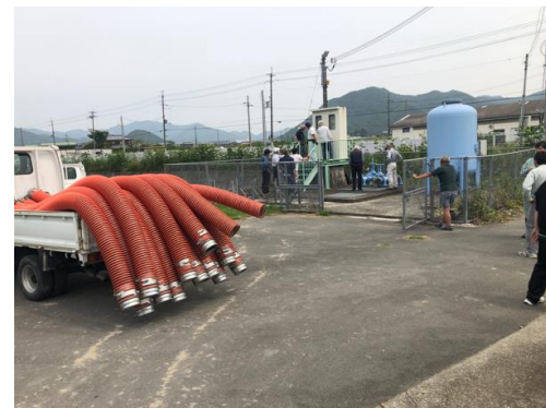
農業用送水ポンプ試運転
