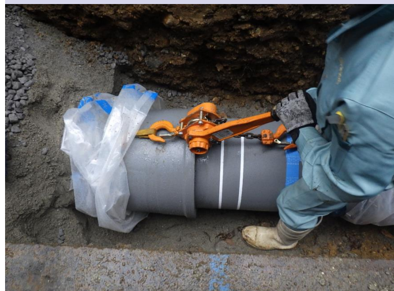
老朽管更新工事(一般部)
