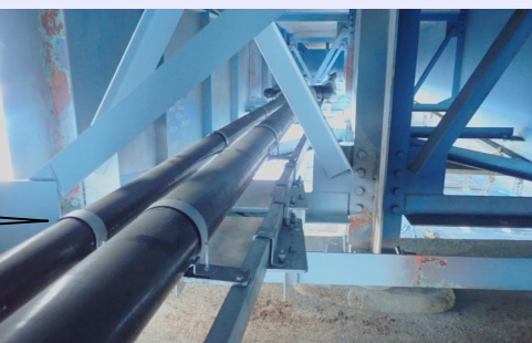
H30-31 県道山南多可線船町橋への添架
