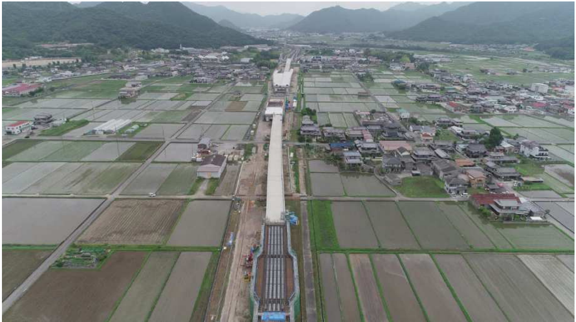
国道175号西脇北バイパス津万高架橋区間
