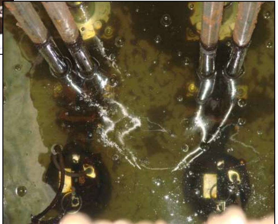
放流ポンプ槽
