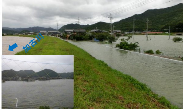
② 幹線排水路堤防嵩上
