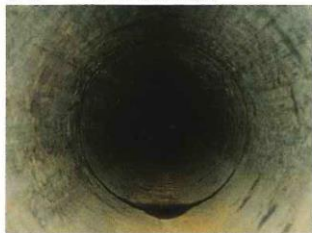
クリーニング施工後
