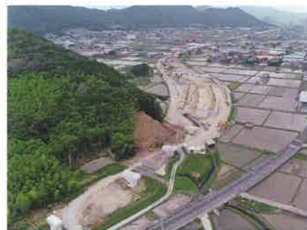
工事の進む(仮称)津万ランプ付近
