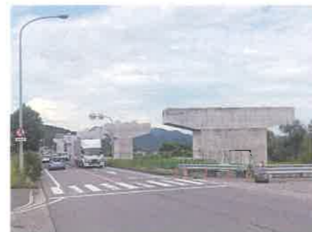
下戸田高架橋区間の整備状況
