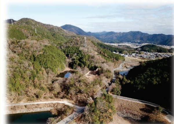
着工前の新施設建設地の様子（令和4年12月）
