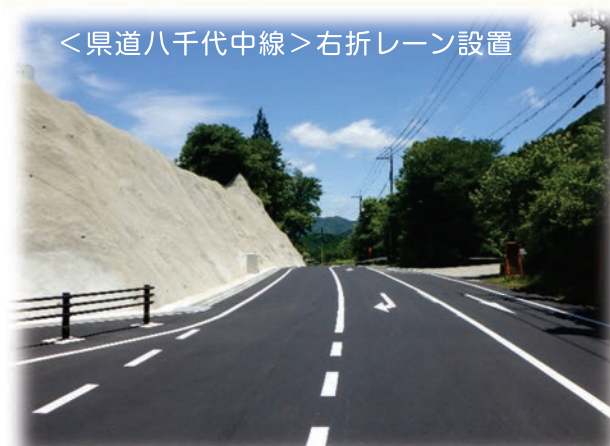
新施設の前面道路（県道部）改良工事完成 （令和8年6月）
