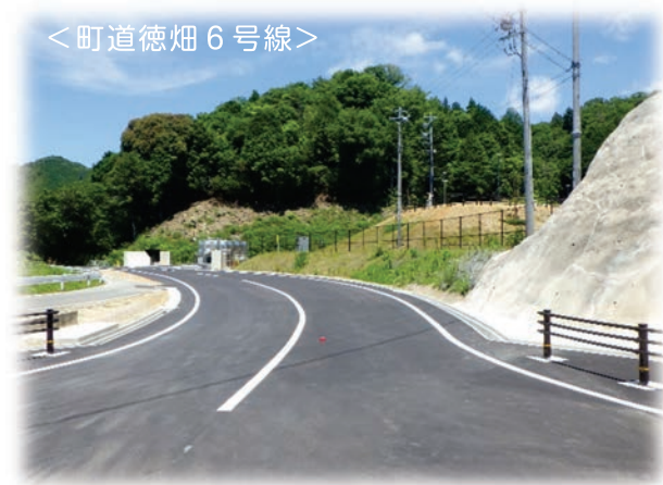
新施設の前面道路（町道部）改良工事完成 （令和8年6月）
