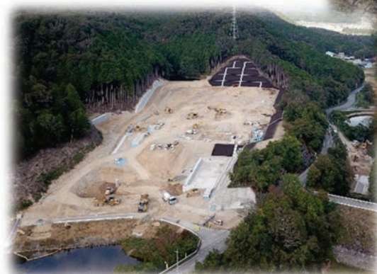
敷地造成工事の様子 （令和5年10月）
