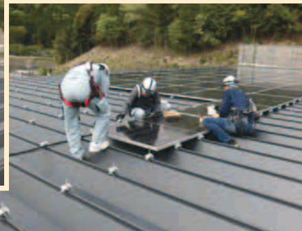
計量棟にも設置しています。
