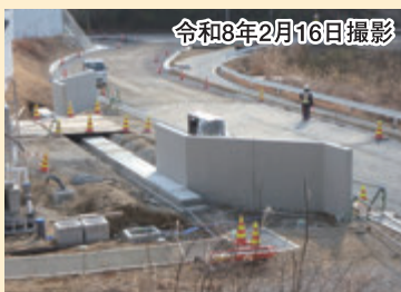
施設正門の施工
