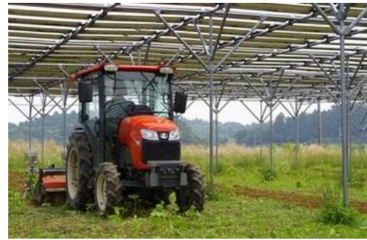
農地の上部空間に太陽光パネルを設置 太陽光パネルの下で農作業 図5-14 営農型太陽光発電について（出典：農林水産省）
