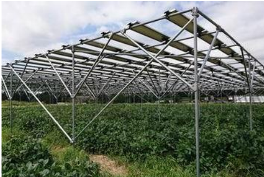
農地の上部空間に太陽光パネルを設置 太陽光パネルの下で農作業 図5-14 営農型太陽光発電について（出典：農林水産省）
