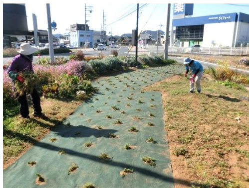
防草シート設置例（しばざくらの丘）
