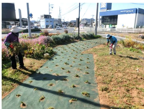
防草シート設置例（しばざくらの丘）
