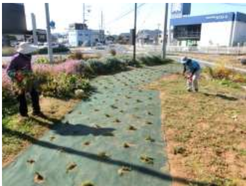
防草シート設置例（しばざくらの丘）
