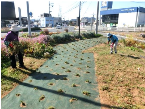
防草シート設置例（しばざくらの丘）
