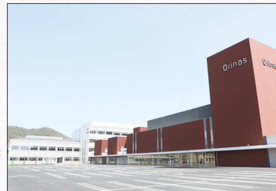
西脇市役所・市民交流施設Orinas
