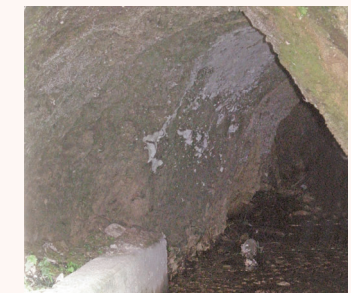
近年まで残っていた素掘りのトンネル
