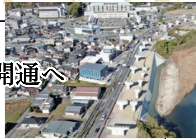
▲高架橋の建設が進む下戸田周辺
