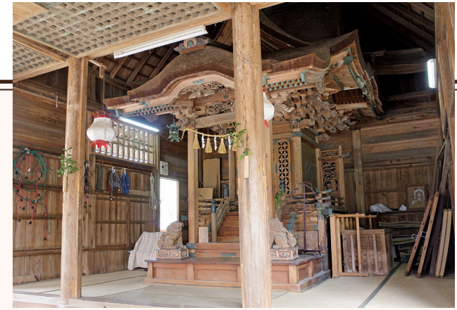
拜殿兼覆屋に収められた本殿
