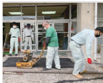
機械を使って段差を埋める工事を 行う市職員
