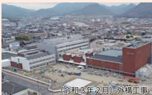
【令和2年11月】建方工事
