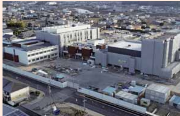
▲工事現場の全景（オリナス建設地）
