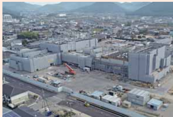
▲工事現場の全景
