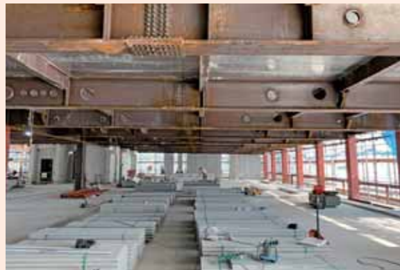
▲工事現場の内部
