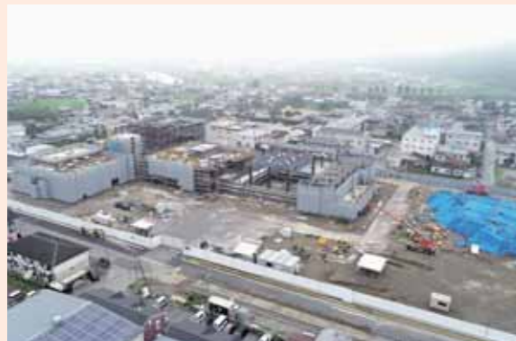
▲建設中の新庁舎・市民交流施設オリナス
