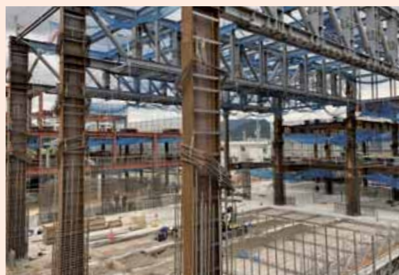
▲市民交流施設ホール部分の鉄骨建方（市民交流施設建設地／7月1日）
