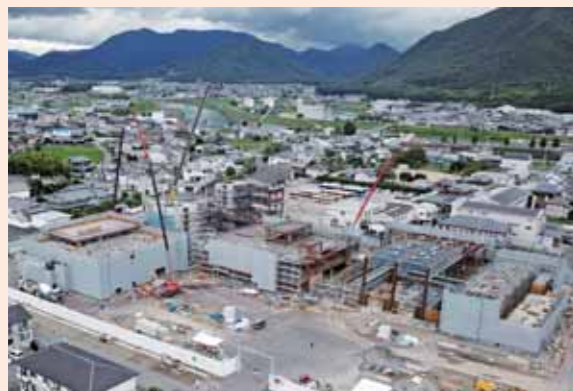
▲工事現場の全景（新庁舎・市民交流施設建設地／7月15日）
