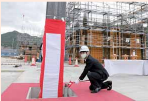
▲立柱式で片山市長らが工事の安全を祈願（新庁舎・市民交流施設建設地／5月20日）
