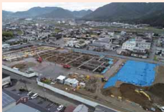
▲工事現場の全景（新庁舎・市民交流施設建設地／4月10日）
