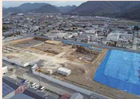
▲工事現場の全景（新庁舎・市民交流施設建設地／2月1日）
