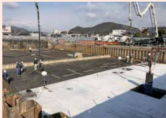
▲工事現場の近景（新庁舎・市民交流施設建設地／2月10日）
