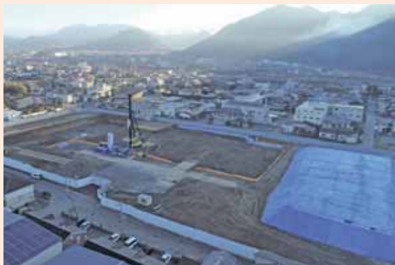
▲工事現場の全景（新庁舎・市民交流施設建設地／1月1日）
