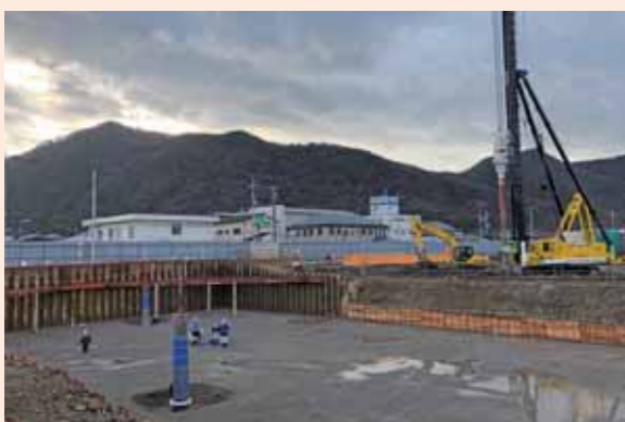
▲工事現場の近景（新庁舎・市民交流施設建設地／1月9日）
