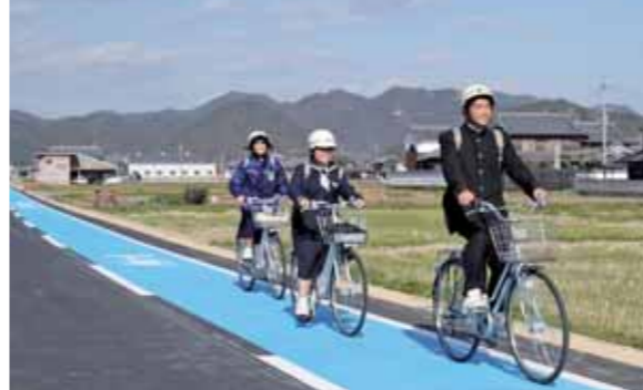
▲幅1.5メートルある自転車専用通行帯。自転車が通行する空間を青く色分け
