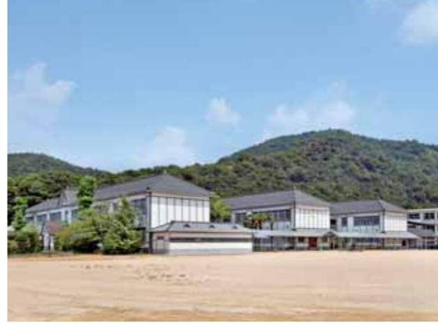
▲改修工事が完了した西脇小学校の木造校舎3棟(左から)
