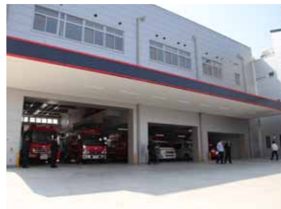
増改築された西脇消防署庁舎
