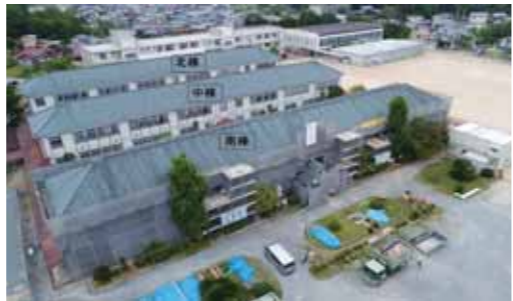
▲南棟から順に改修工事を進めています
