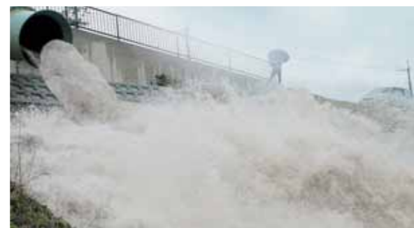
▲放流する下戸田ポンプ場
