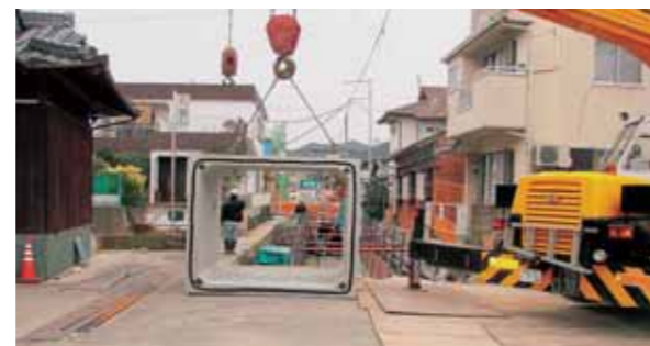
▲雨水幹線排水路の整備工事
