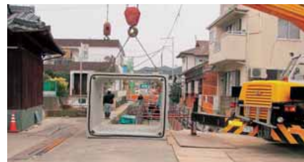
▲雨水幹線排水路の整備工事
